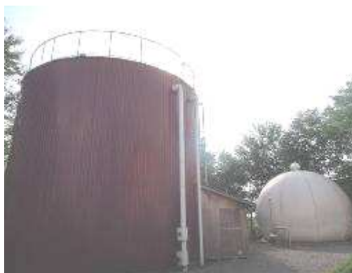
図表 IV-2 メタン発酵槽（左）およびガスホルダー（右）
