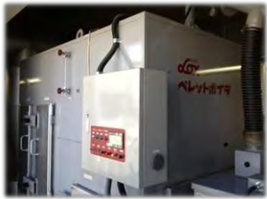
写真: ペレットボイラー(左)、燃焼部分(右)
