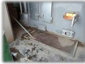
写真: サイロとボイラー(左)、基礎部の灰処理用の溝(右)
