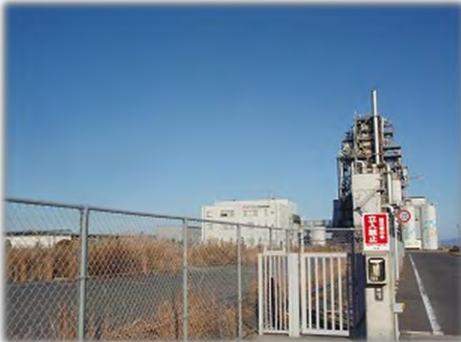
写真:「ミツウロコ岩国発電所」施設外観
