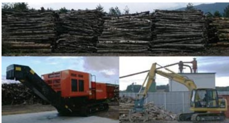
写真 5.5 国内チップ製造工場の土場と機械設備
