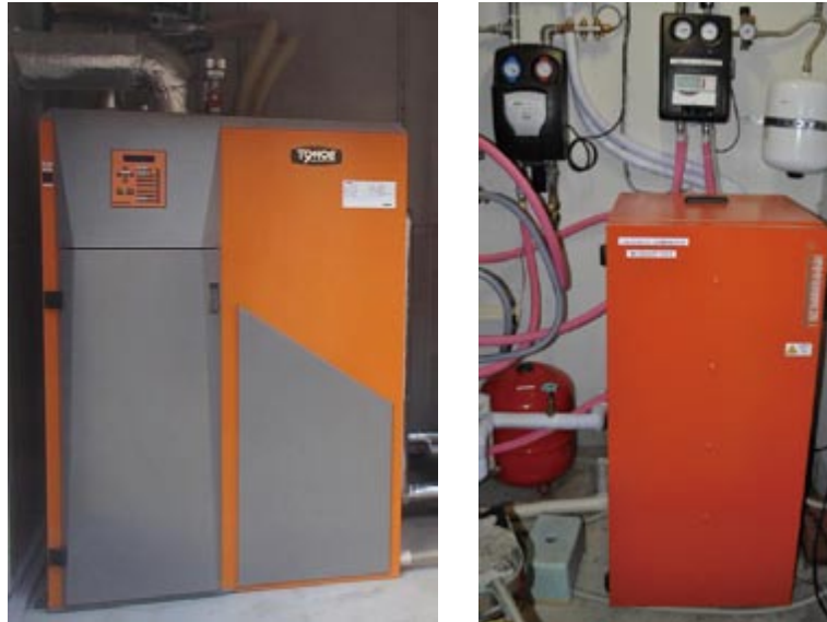
写真 7.2 家庭用ペレットボイラー導入事例
