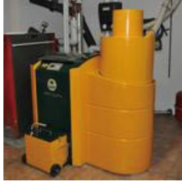
写真 7.9 小型ペレットボイラー (KWB)
