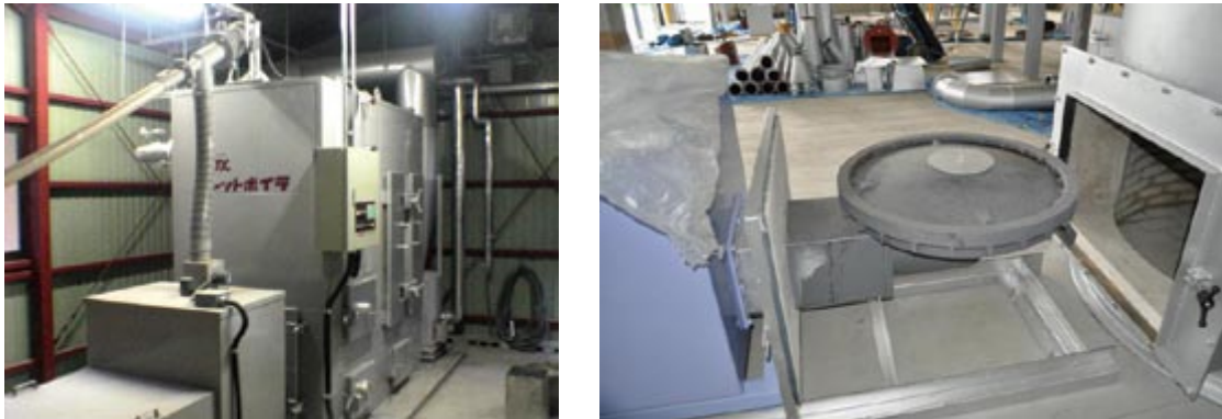
写真 7.4 国産ペレット焚き温水ボイラーとバーナーの構造 (二光エンジニアリング)
