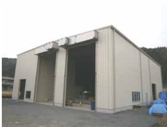
図表 4-11 チップボイラ設置工事の状況写真（2015 年 3 月 16 日時点）
