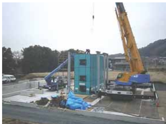
図表 4-10 チップボイラ設置工事の状況写真（2015 年 1 月 28 日時点）
