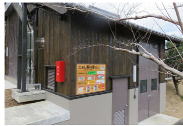
ボイラー機械室
