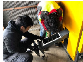
ボイラー設置工事作業
