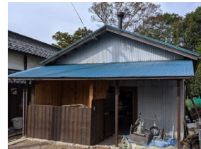
空き倉庫を利用した ボイラー室
