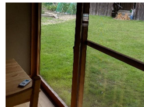
断熱改修)ペアガラス入りの地元産木製サッシ
