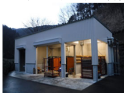
薪ボイラー棟
