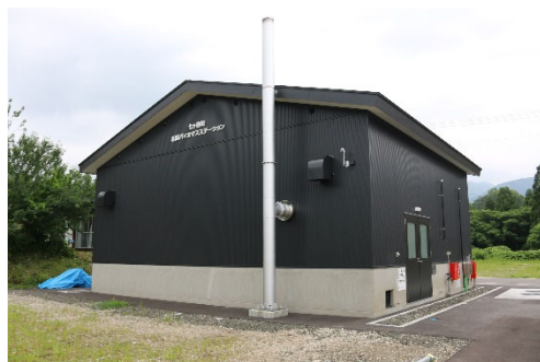
七ヶ宿町 木質バイオマスステーション
