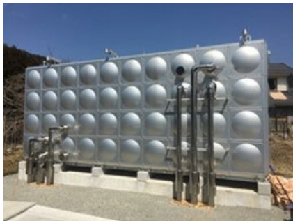
蓄熱槽を利用することで、必要最小限の木質チップを効率的に使用
