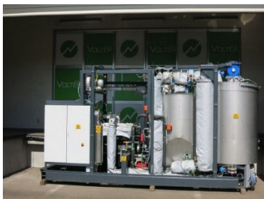
超小型バイオマス発電機 Volter40
