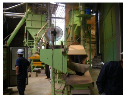
木質ペレット製造施設(有)安岡重機
