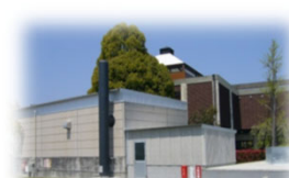
〔ボイラー室とチップサイロ〕
