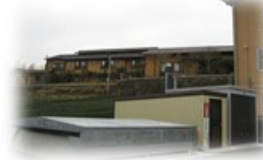
〔ボイラー室とチップサイロ〕
