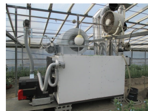
木質ペレットボイラー (㈱相愛社製)
