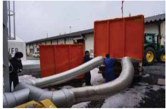
写真 2.13 排煙の送風口と送風ダクト
