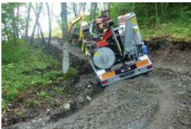
写真 2.10 路体強度が弱く森林作業道の路肩に車輪が埋まったけん引式チップー機
