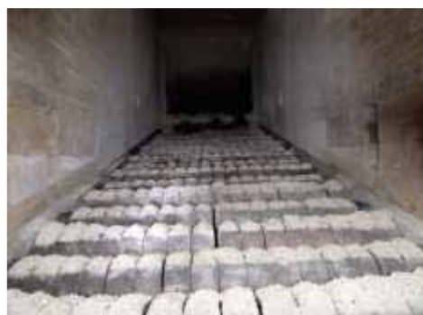
写真 4.1 燃焼炉内火格子
