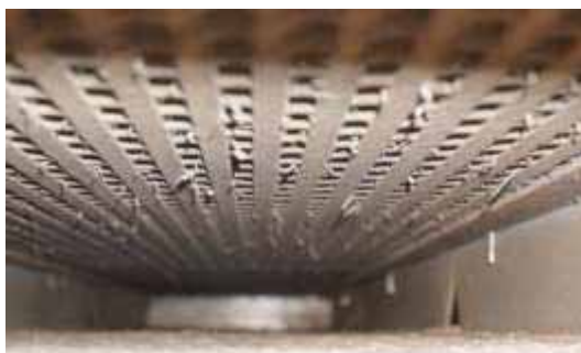
写真 2.12 強制乾燥終了直後の送風口の状況
