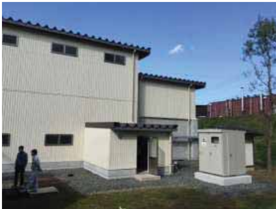
写真 4.3 大型ボイラ写真
