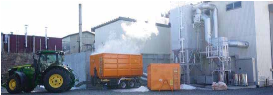
写真 2.15 排煙と二重底コンテナを利用した木くず燃料の強制乾燥システム全景
