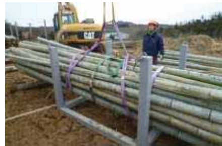
写真 5-62 スリングによる吊り上げ
