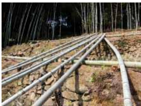
写真 5-21 等高線上への竹の配置
