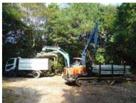
写真 5-16 箱ダンプトラックへの積込
