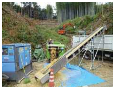
写真 5-38 ベルトコンベアによる積込
