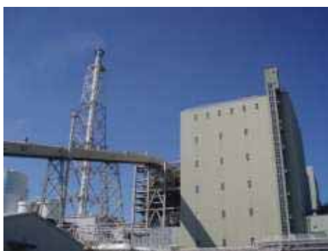
写真 3-1 中国電力(株)新小野田発電所
