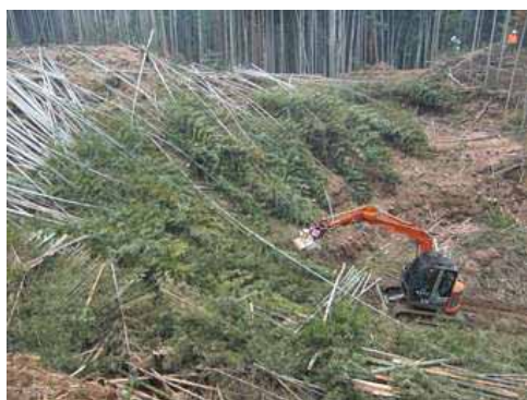
写真 5-35 フェラーバンチャによる集材
