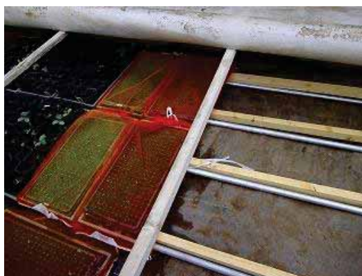
図-72 苗床と温水配管
