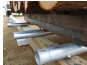
⑫レールを固定させ、 設置終了
