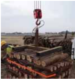
⑦ユニックで吊り上げ 荷台へ
