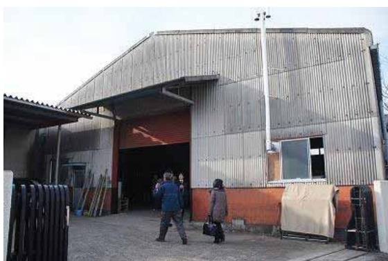
図- 83 倉庫 (ストックヤード)
