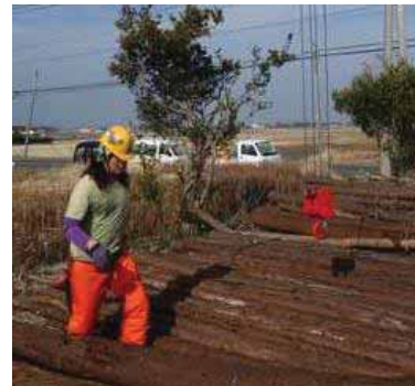
③材を吊り上げて動かす
