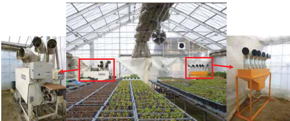
図- 57 430 m 2 温室内の重油暖房機 (左) と木質バイオマス暖房機送風ダクト (右)
