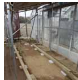
⑨設置場所に レールを設置
