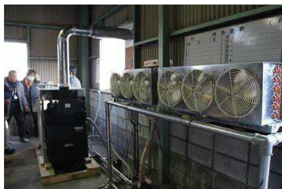
図- 84 暖房機 (NO. 401) と熱交換ファン
