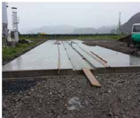
木材乾燥施設の施工状況(8月27日現在)
