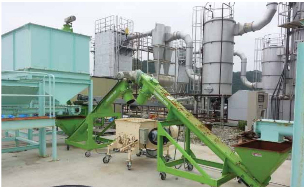
図 4-18 実証施設（灰資源化設備、北側から撮影）（平成 27 年 6 月 30 日撮影）
