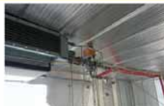
内部エアコンの設置(8月27日現在)
