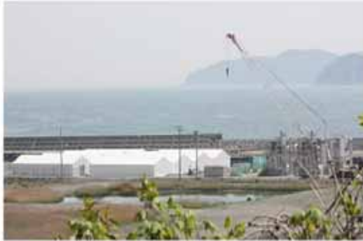
写真、バイオマスボイラの右側に8棟建設中 (山側より撮影)
