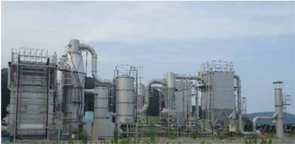
図 4-15 実証施設写真（平成 27 年 8 月 7 日撮影）
