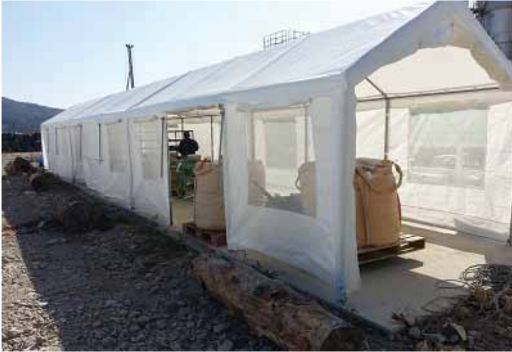
図 4-17 実証施設（灰資源化簡易建屋、北側から撮影）（平成 27 年 10 月 26 日撮影）
