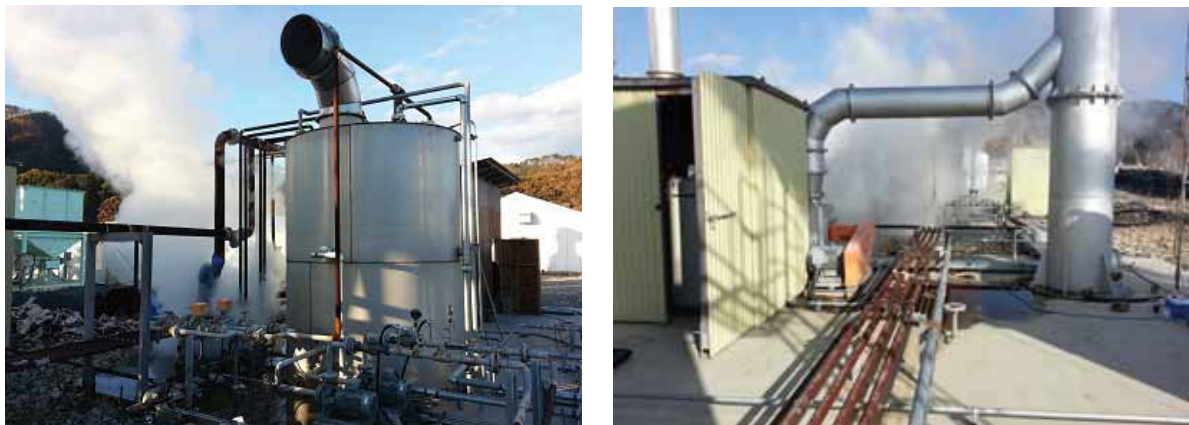
図 4-16 実証施設写真（平成 27 年 11 月 11 日撮影）
