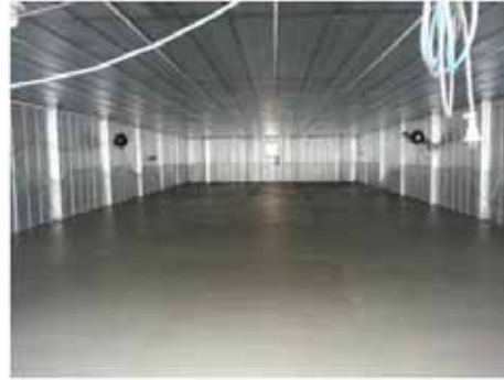
図、菌床しいたけ栽培施設の内張り、土間工事 (7月8日現在、2棟の状況)
