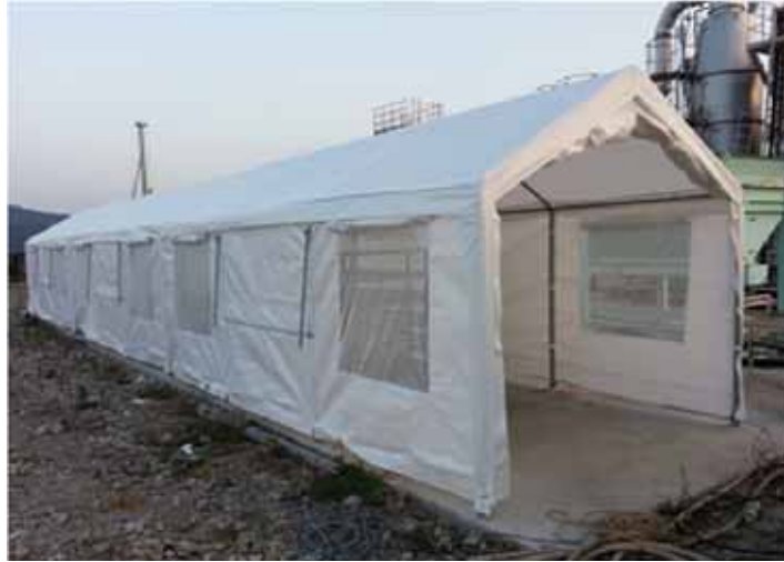
図 9-5 簡易建屋の設置
