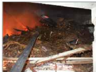
燃焼炉内の様子 (平成26年12月5日撮影)
