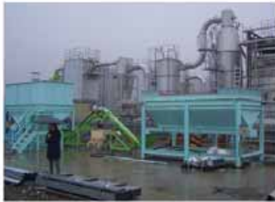
灰資源化施設(平成27年3月9日撮影)
