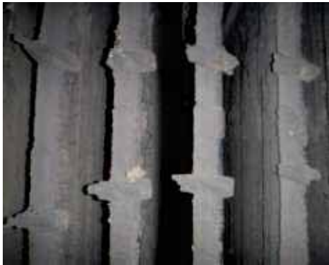
2SH伝熱管クリンカー付着状況
