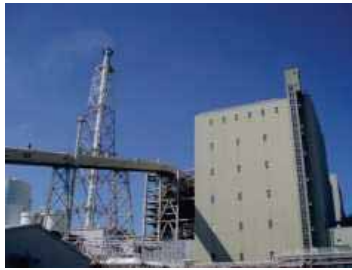
中国電力(株)新小野田発電所
