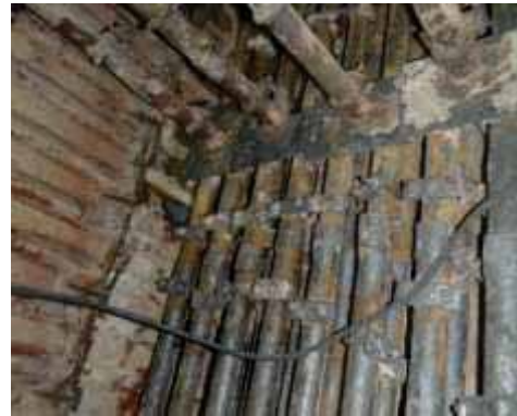
2SH伝熱管クリンカー清掃後
