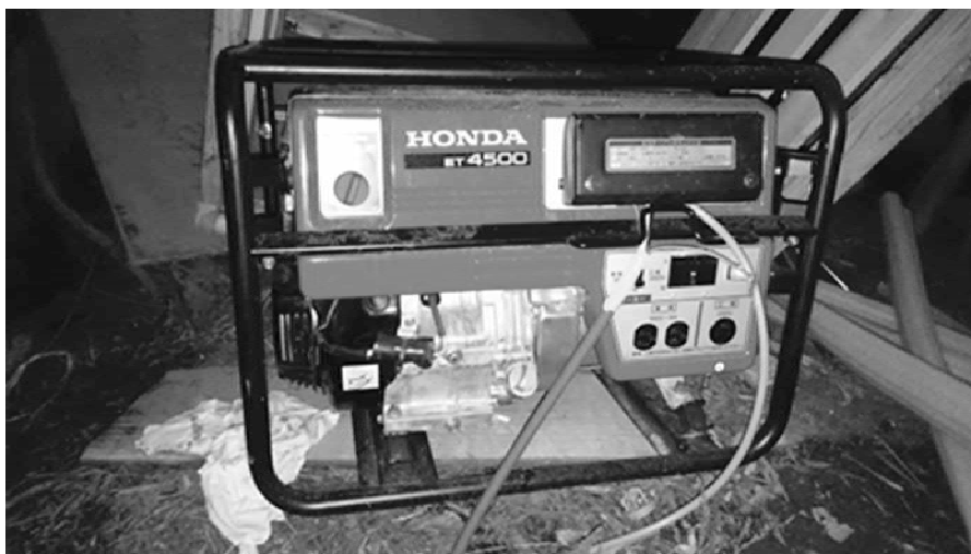
図表 279 導入した非常用発電機の外観
