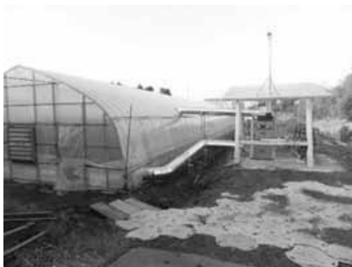
図表 117 丸太加温器内への接続配管
