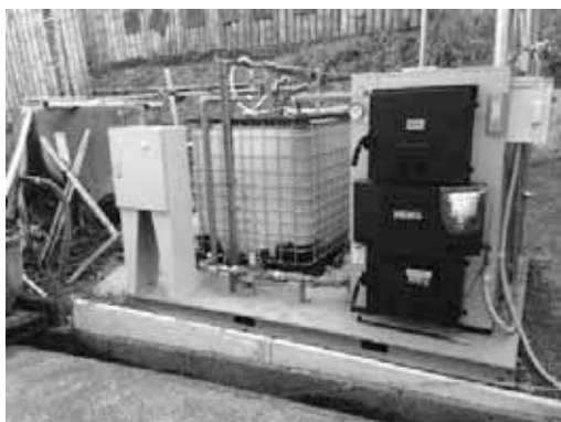
図表 209 丸太加温器および熱交換器の設置状況
