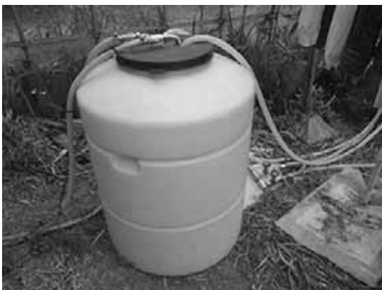
図表 114 貯湯タンク
