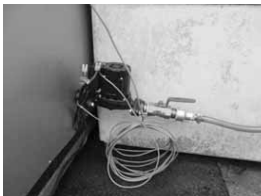
図表 149 循環ポンプ
