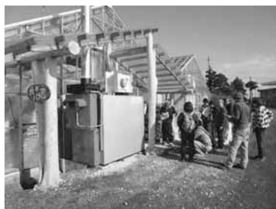
図表 72 丸太加温器の設置状況
