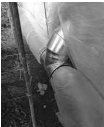
図表 101 ハウス内への吹き出し口
