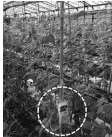
図表 100 室内温度計の設置
