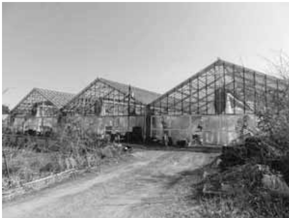
図表 122 ハウスの外観
