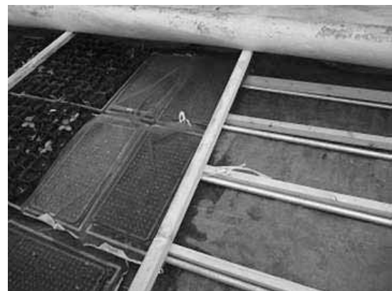
図表 115 苗床と温水配管
