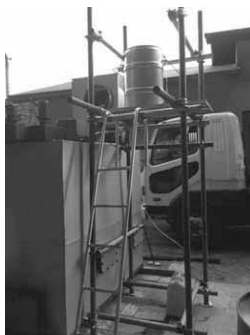
図表 276 バーナー用重油タンクの取り付け状態（全体）
