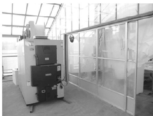
図表 195 丸太加温器の設置状況
