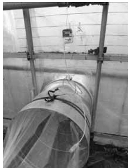
図表 120 ハウス内への吹き出し口
