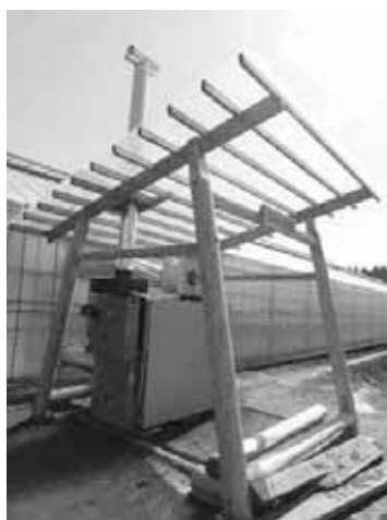
図表 78 丸太加温器の設置状況
