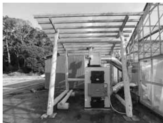
図表 138 丸太加温器の設置状況
