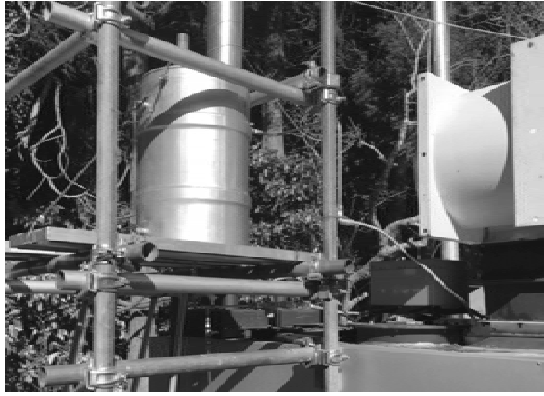
図表 277 バーナー用重油タンクの取り付け状態
