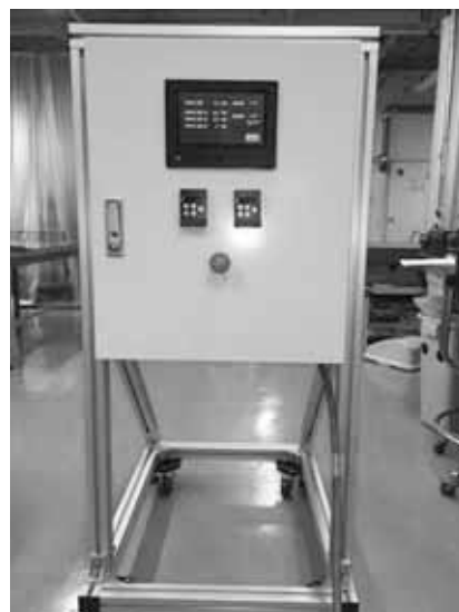
図表 272 温風・温水ハイブリッド器の制御盤
