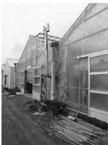
図表 76 ハウスの外観
