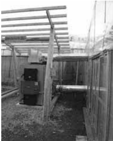
図表 99 丸太加温器とハウス内への接続
