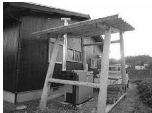
図表 93 丸太加温器の設置状況
