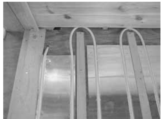
図表 91 床下の配管
