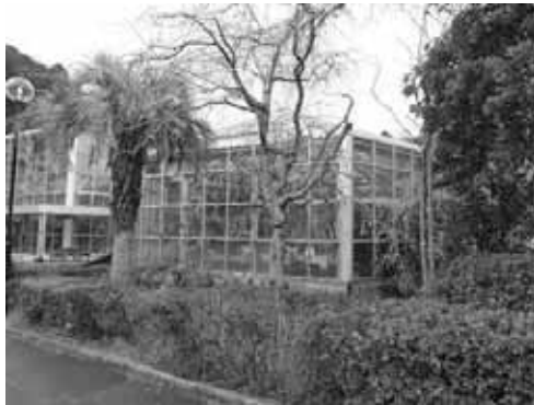
図表 159 温室の外観
