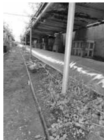
図表 130 チューブの設置状況
