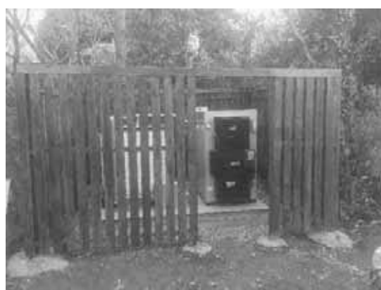
図表 84 丸太加温器の設置状況
