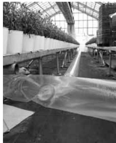
図表 125 ダクトの様子
