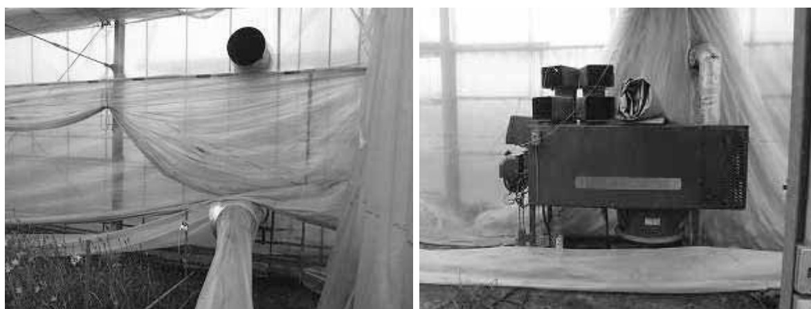
図表 187 重油加温器とハウス内部
