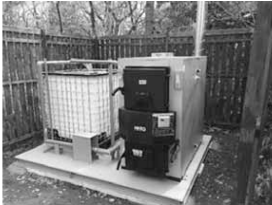
図表 220 丸太加温器と熱交換器の設置状況
