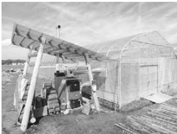
図表 105 丸太加温器の設置状況
