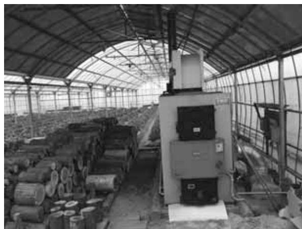
図表 145 丸太加温器と丸太置場
