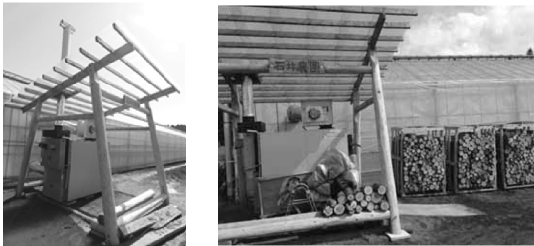
図表 186 丸太加温器の設置状況
