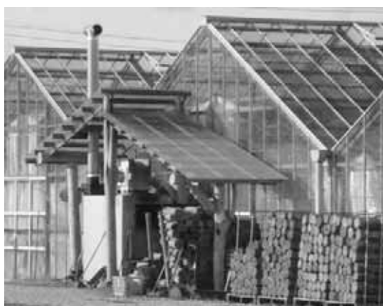
図表 174 丸太加温器の設置状況
