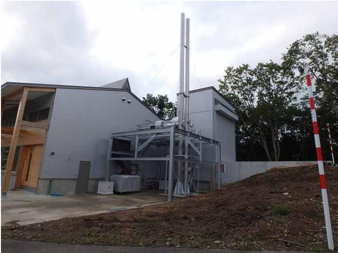
煙突改修 二次燃焼装置+煙突 5m 延伸
