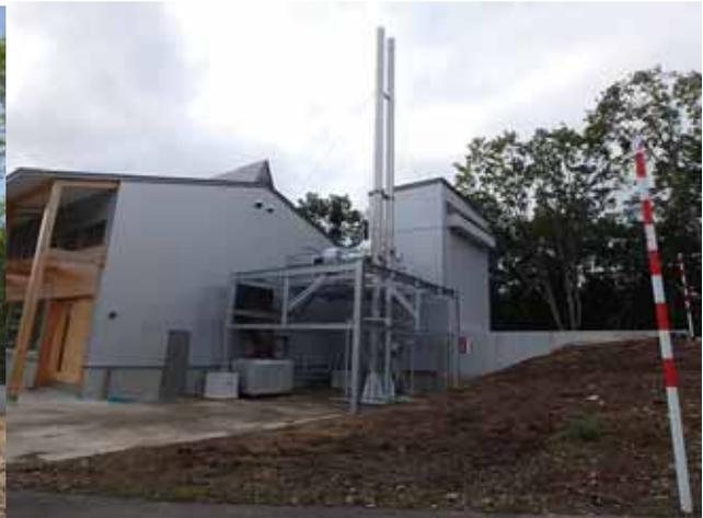
二次燃焼装置+煙突5m 延伸完了
