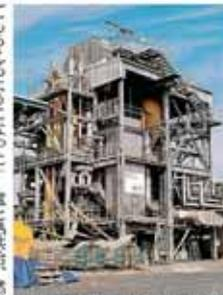
木質バイオマスをガス化して発電、熱供給、燃料用ガスに利用する実証研究施設—キュッシング市
