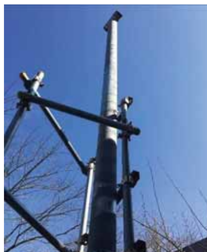
図 4-70 丸太加温器の煙突
