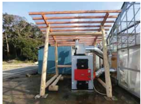
図 4-43 丸太加温器の設置状況
