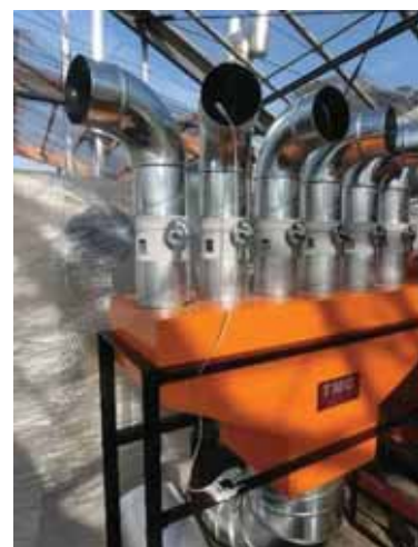
図 4-45 丸太加温器ダクト
