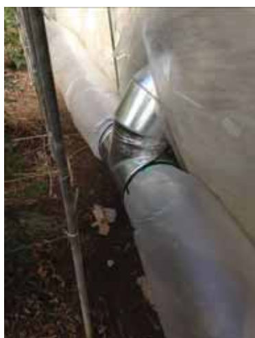
図 4-24 ハウス内への吹き出し口
