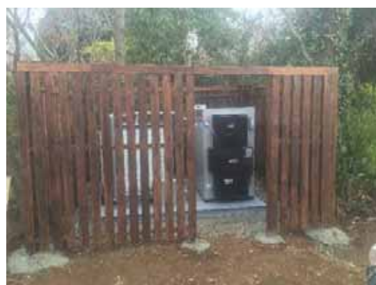
図 4-6 丸太加温器の設置状況
