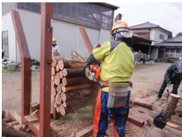
図 3-23 治具を使用した加工の様子
