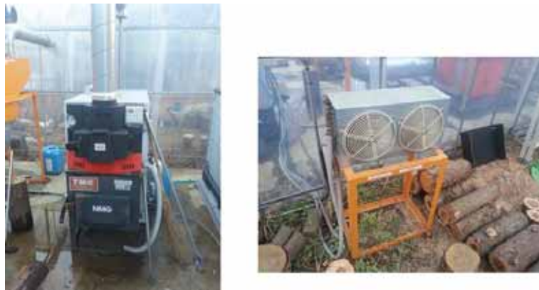
図 4-97 大学に設置した温水型丸太加温器と送風ファン（温水熱交換）
