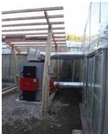
図 4-22 丸太加熱器とハウス内への接続
