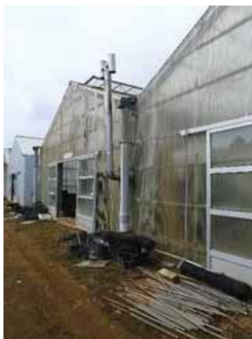
図 4-8 ハウスの外観
