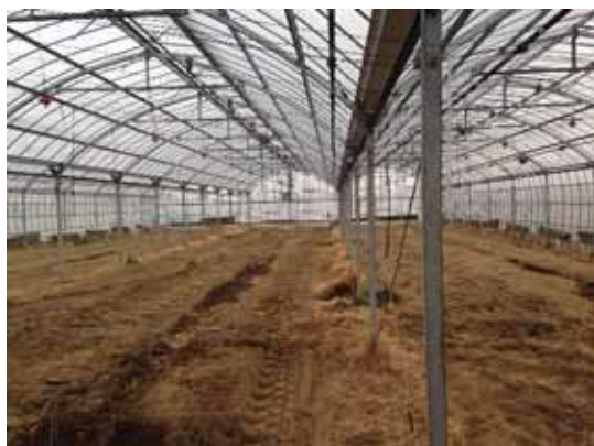
図 4-32 ハウス内部の状況
