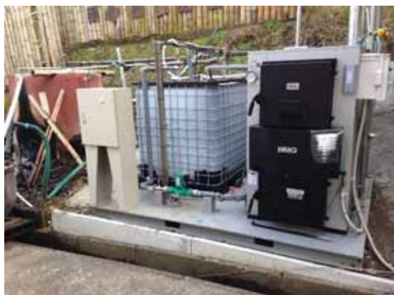
図 4-69 熱交換器と丸太加温器
