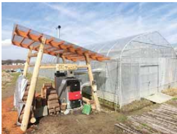
図 4-53 丸太加温器の設置状況
