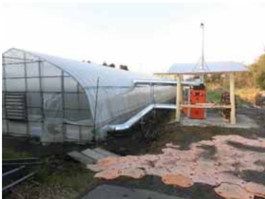
図 4-27 丸太加温器内への接続配管
