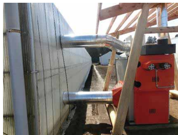
図 4-11 丸太加温器内への配管
