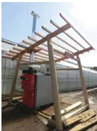
図 4-10 丸太加温器の設置状況
