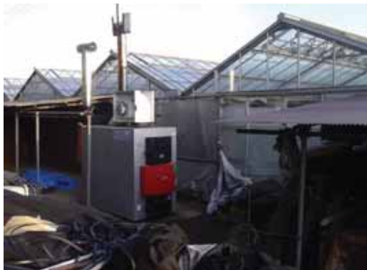
図 4-62 丸太加温器の設置状況
