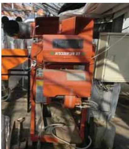
図 4-44 重油暖房機ダクト
