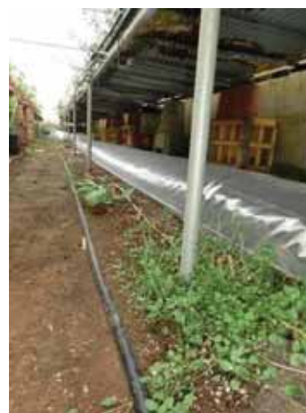
図 4-50 チューブの設置状況
