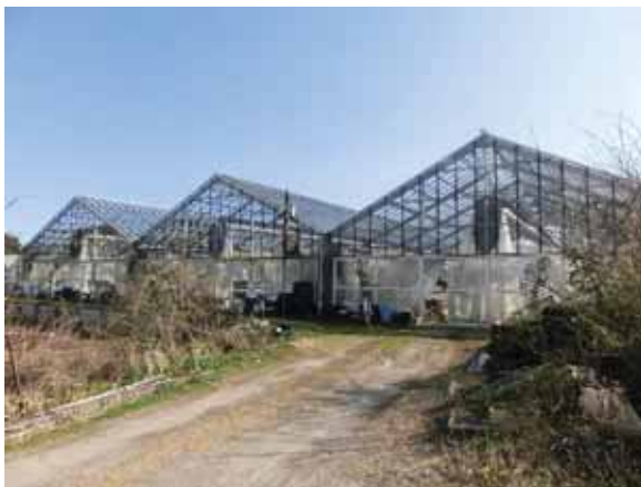
図 4-37 ハウスの外観
