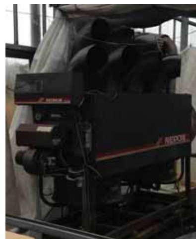
図 4-40 既存重油暖房機
