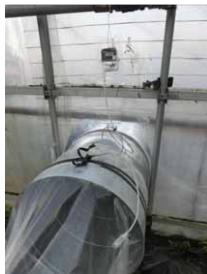
図 4-30 ハウス内への吹き出し口
