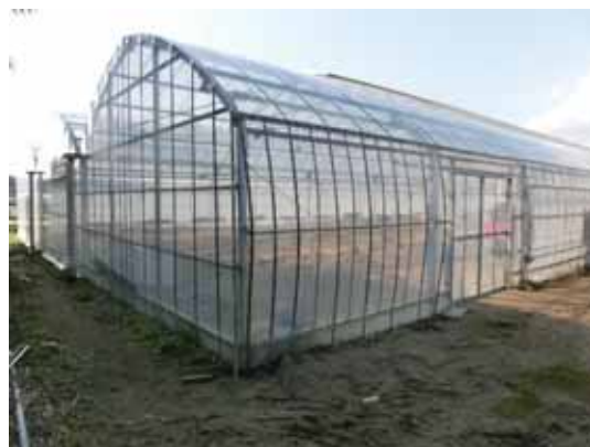
図 4-33 ハウスの外観
