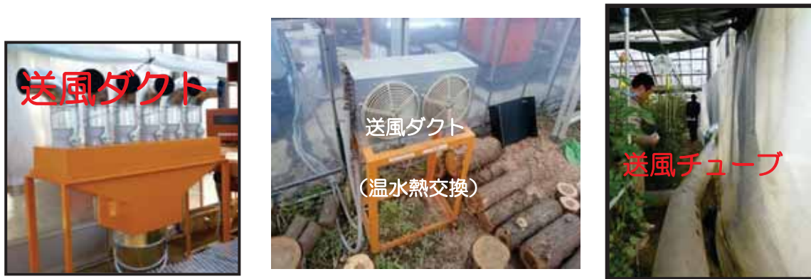
図 4-109 丸太加熱器からの送風方法
