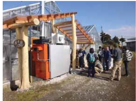
図 4-73 丸太加温器の設置状況
