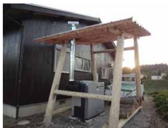
図 4-20 丸太加温器の設置状況
