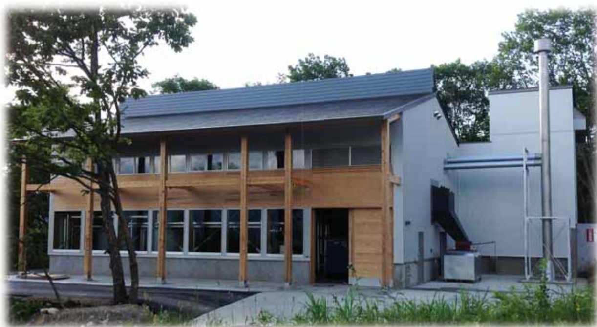
2-5 環境ショーケース型機械室（※集成材使用、県産材軒柱使用、環境学習用遊歩道）
