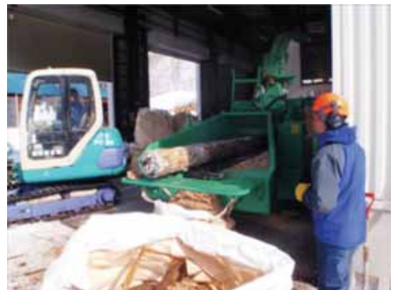
間伐材投入状況
