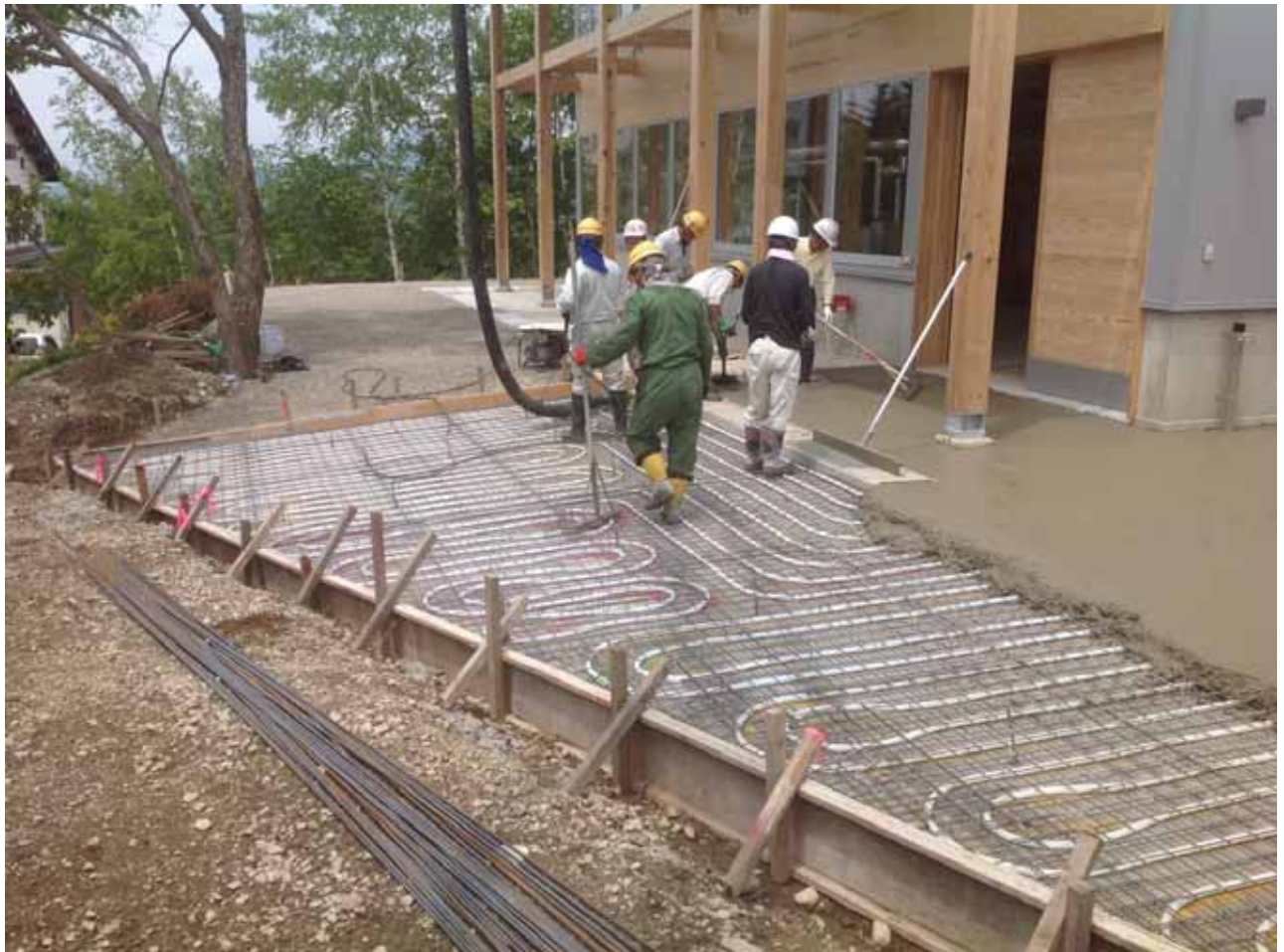
2-9 無散水融雪配管工事風景
