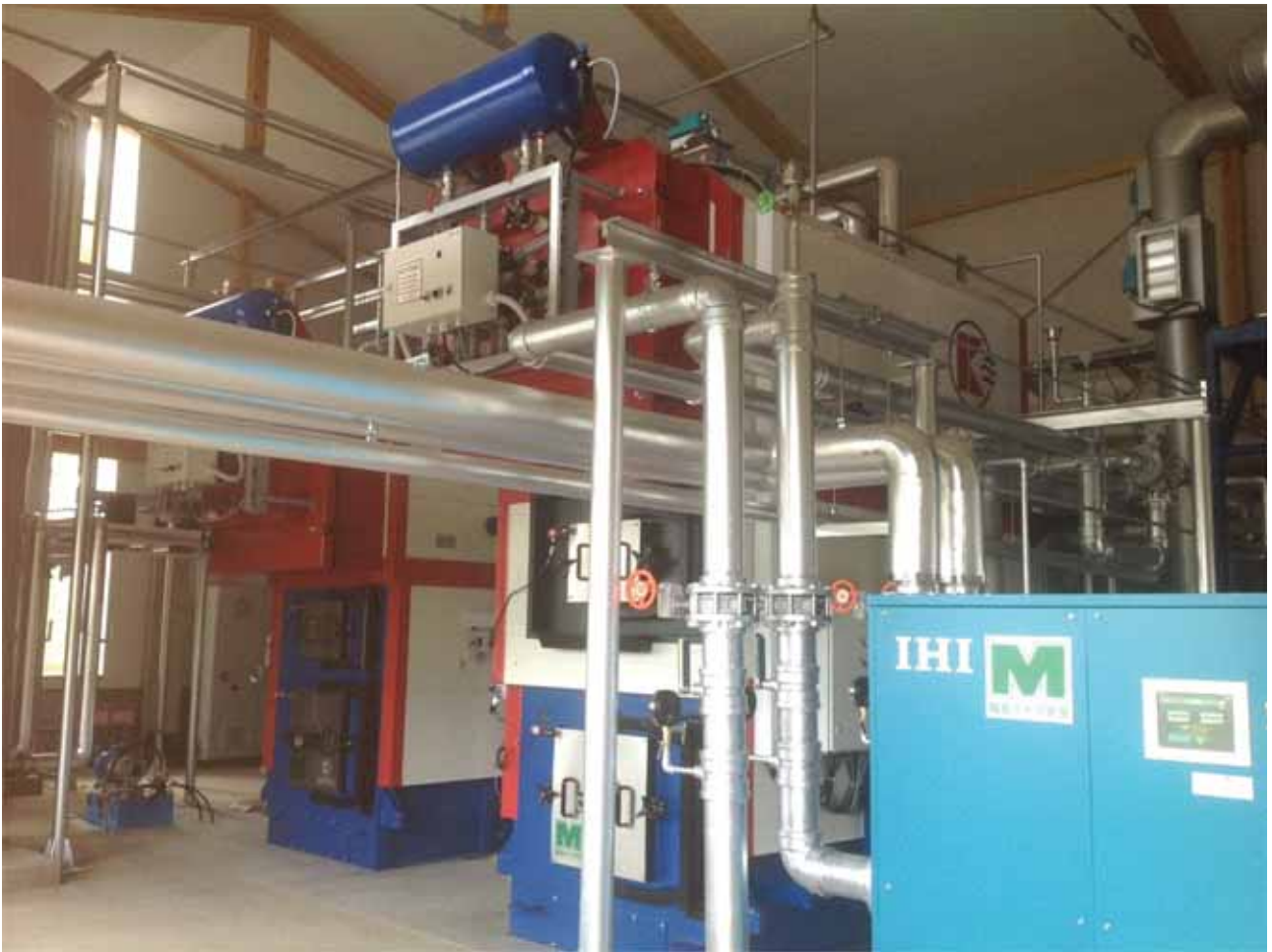
2-3 熱供給源設備 木質バイオマスボイラ 600kw/400kw 2 基設置工事/小型バイナリボイラ発電機 20kw1 基設置工事
