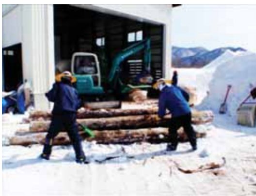
人力皮剥状況
