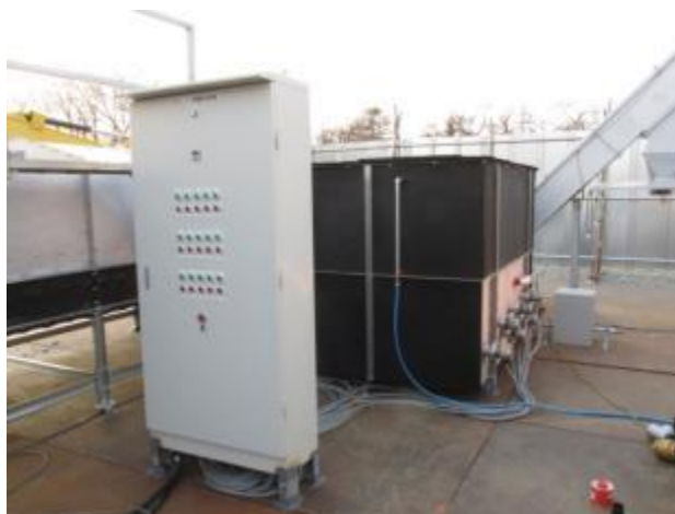
図 16. 負荷電源盤・貯湯槽
