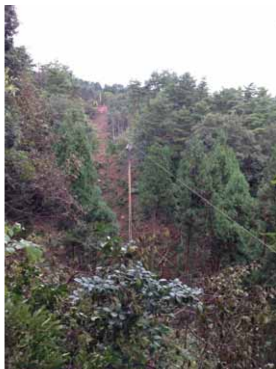
【架設に使用したバンド等をワイヤー引き揚げ時に元柱側に撤収】
