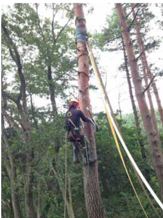
【滑車等の取り外し】
