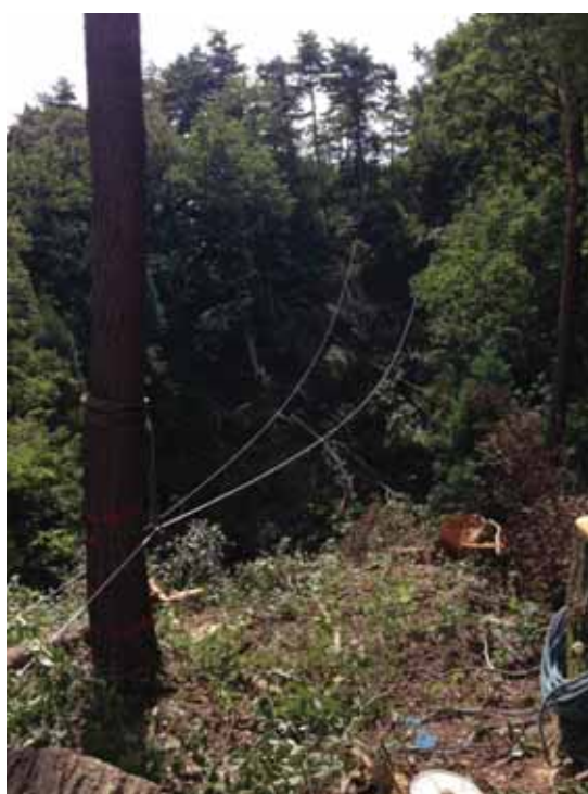
【リードロープ(繊維)の引き回し】中間支持機を活用。※集材時には中間支持機を利用していない。
