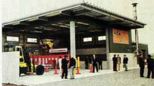
温泉旅館「美松」の熱源として稼働した木質チップボイラー施設＝あわら市舟津で
