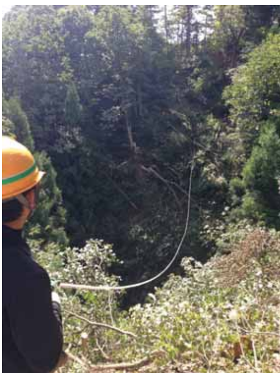
【リードロープ(繊維)の引き回し】 元柱から先柱まで人力で運ぶ。
