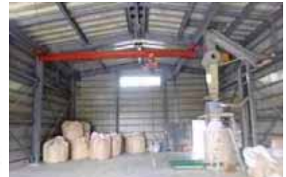
写真-保管内ホイストクレーン
