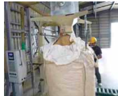
写真-フレコン詰め機
