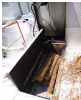
追加燃料投入口
