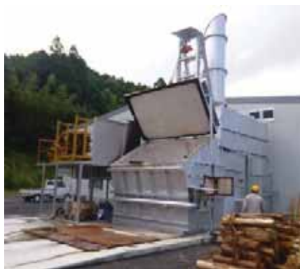
バイオマスボイラー（熱風炉）
