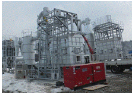
①バイオマスボイラ
