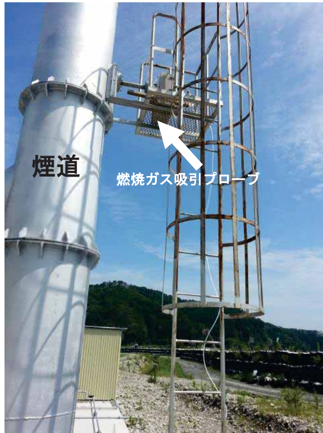
図 9-4 燃焼ガス吸引プローブの設置状況
