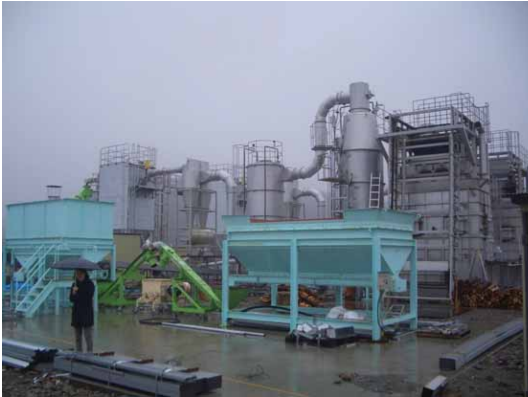
図 4-9 実証施設（北側から撮影）（平成 27 年 3 月 9 日撮影）
