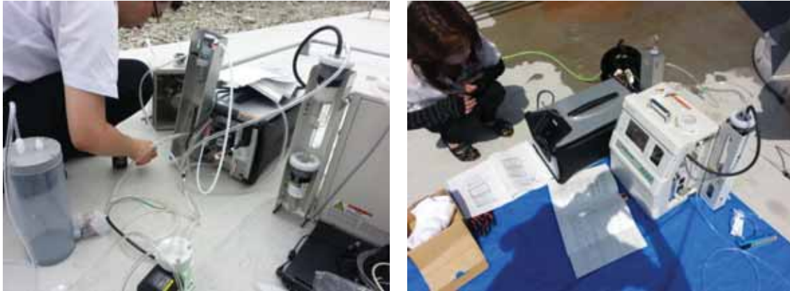
図 9-2 配管作業の様子
