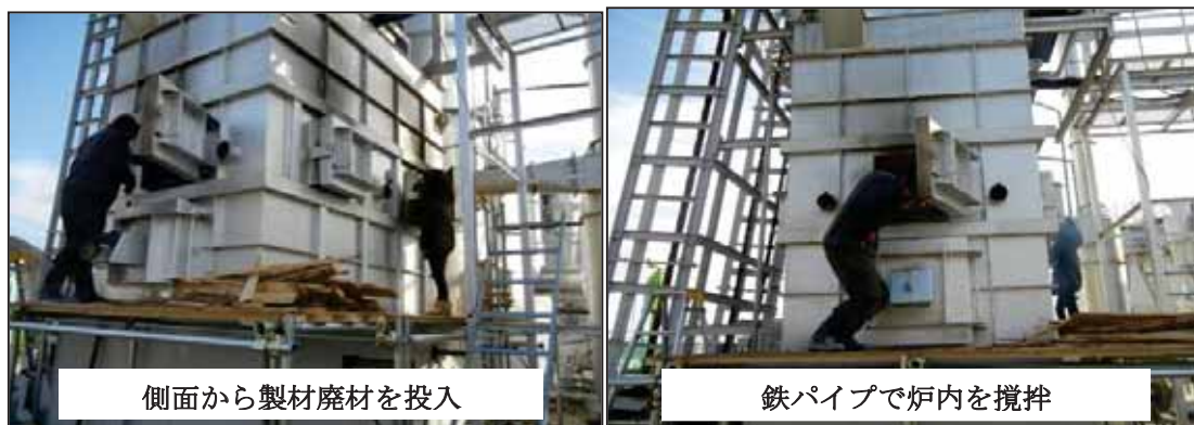
図 7-5 燃焼状態改善措置
