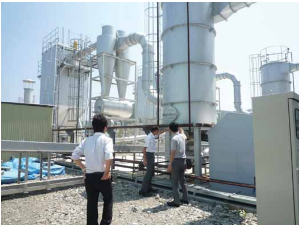
図 3-3 実証施設現場（平成26年7月30日撮影）
