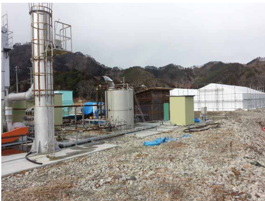
図 4-8 実証施設写真（平成 27 年 2 月 9 日撮影）
