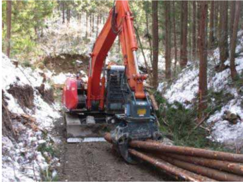
図 6. スイングヤーダー付バックホウ：木材の牽引、切断の機能が付いたグラップル
