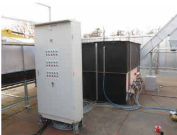
図 32. 負荷電源盤・貯湯槽
