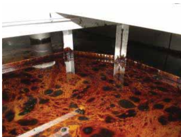
図 37. 木酢液、バイオオイルの貯蔵タンク
