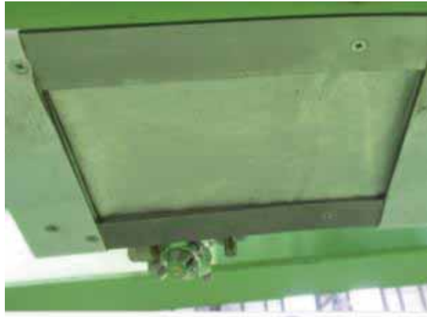
図 51. 測定機の保護カバーの状態
