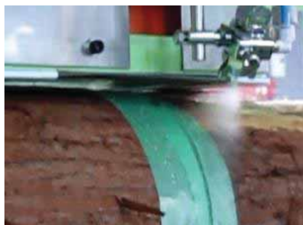
図 53. 汚染箇所をマーキングしている状況
