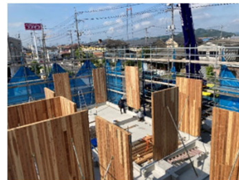
木造事務所建設の様子
