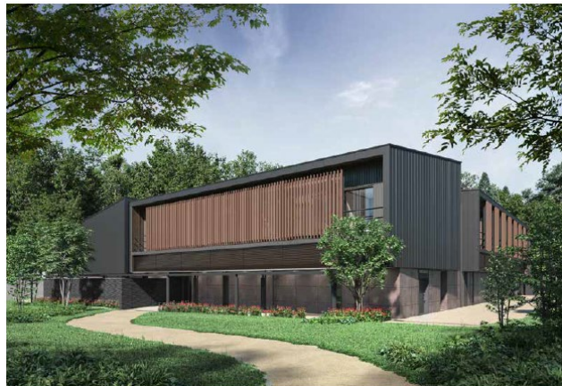
CLT ユニット工法による準耐火木造ホテル
