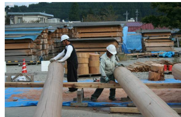
地元大工による丸太材の加工
