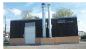
木質バイオマス熱利用施設
