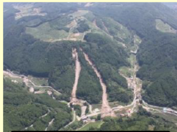
山腹崩壊の発生状況
