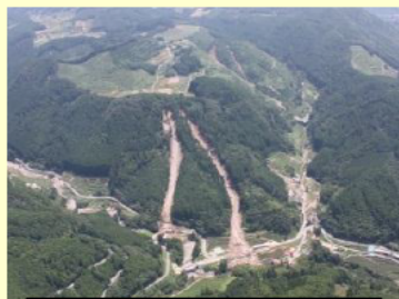
山腹崩壊の発生状況
