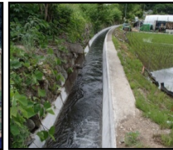
老朽化した用水路の整備・更新
