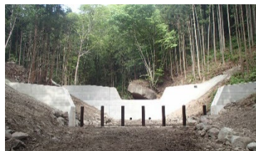
流木捕捉工の設置
