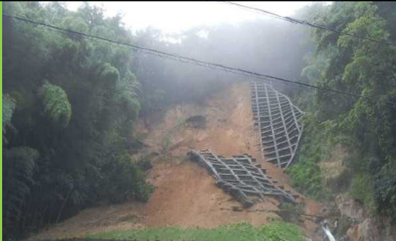
令和3年8月の大雨による林道の崩壊
