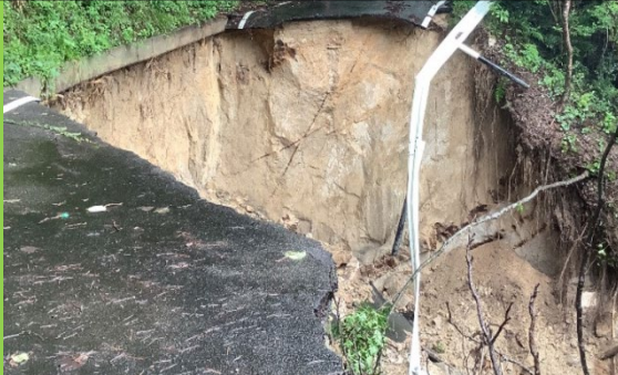
令和3年8月の大雨による林道の崩壊
