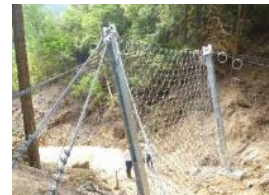
簡易な構造物による応急対策
