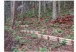
移動抑制対策(筋工)
