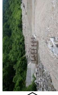
治山ダムに異常堆積した土石・流木の除去
