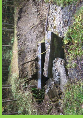
林道施設の復旧
