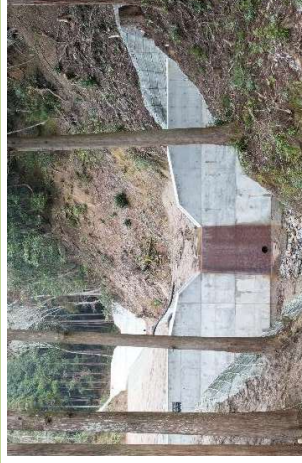
土砂流出を防止する治山ダムの整備
