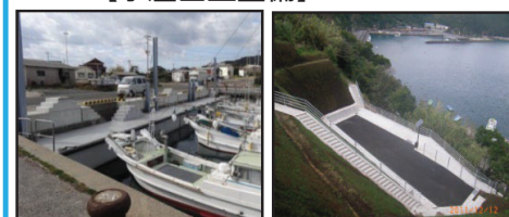
漁業作業の効率化と安全対策のための漁港整備（岸壁改良） 漁村における津波避難対策（避難施設、避難経路の整備）
