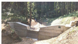
土砂流出を防止する治山ダム群の整備
