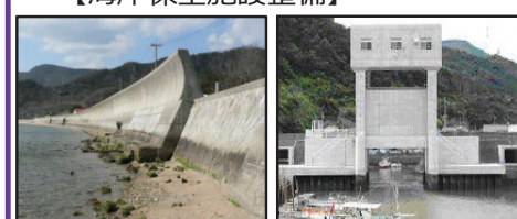
津波、高潮による被害を未然に防ぐため海岸堤防の整備を推進 津波・高潮対策としての水門整備
