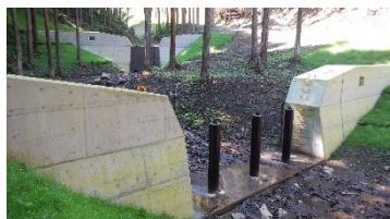
流木捕捉式治山ダムを設置
