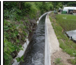
老朽化した用水路の整備・更新
