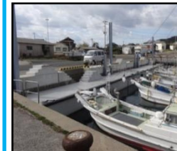
漁業作業の効率化と安全対策のための漁港整備（岸壁改良）
