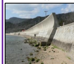
津波、高潮による被害を未然に防ぐため海岸堤防の整備を推進
