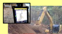
ICT建機による土工
