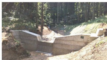
土砂流出を防止する治山ダム群の整備
