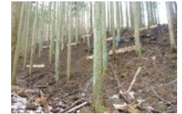
移動抑制対策(筋工)
