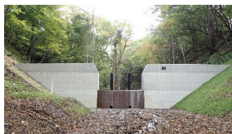
流木捕捉式治山ダムの設置
