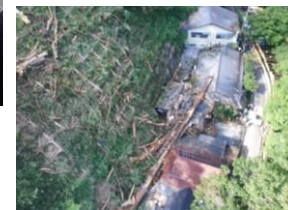
人家近接地における 危険木被害
