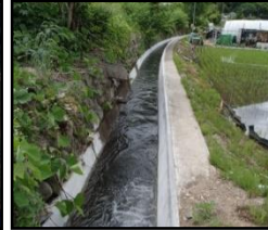
老朽化した用水路の整備・更新
