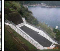
漁村における津波避難対策のための津波避難地、避難路の整備
