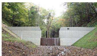
流木捕捉式治山ダムの設置
