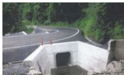
排水工の設置
