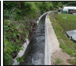
老朽化した用水路の整備・更新
