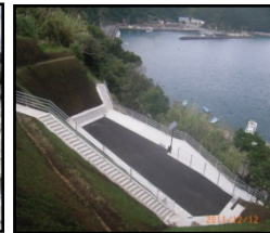
漁村における津波避難対策のための津波避難対策（避難地、避難路の整備）
