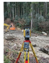
レーザスキャナを用いた3次元起工測量
