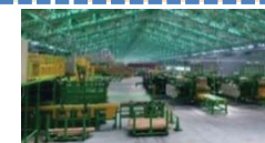
木材加工流通施設整備
