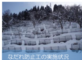
なだれ防止工の実施状況
